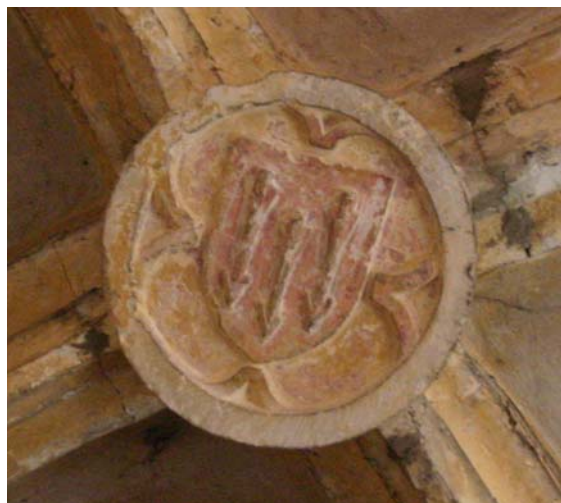
Clé de voûte armoriée dans la galerie
